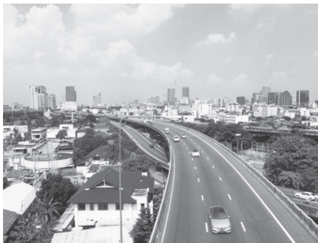
バンコク市内を走る高速道路と高層ビル
