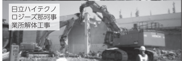
工事実施の様子
