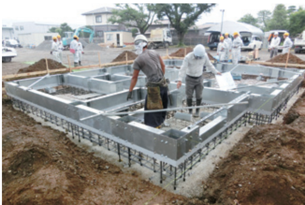
新工法「Hi-MS」の試験施工の様子 (特許出願中)
