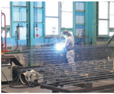
溶接作業の様子
