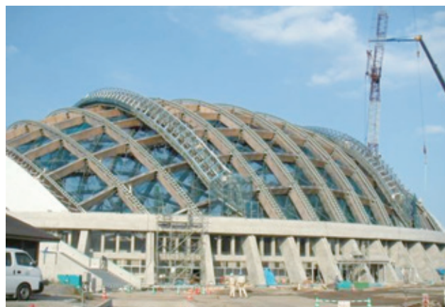
■木の花ドーム (建設中写真)
