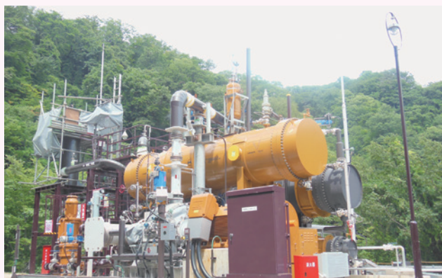
土湯のバイナリー型発電機（オーマット社製） 出所：つちゆ温泉エナジー(株)
