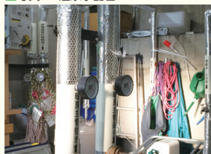
■写真2 温泉水配管
