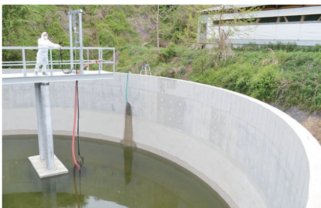
直径18mの大型浄化槽を建設中
