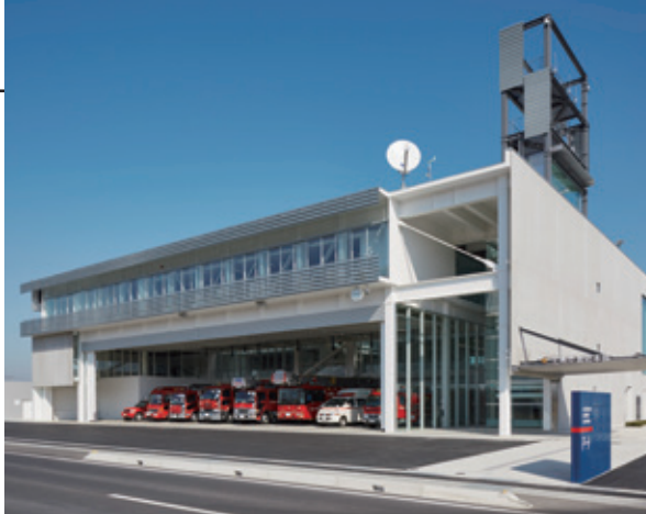
土浦市新消防庁舎建設工事
