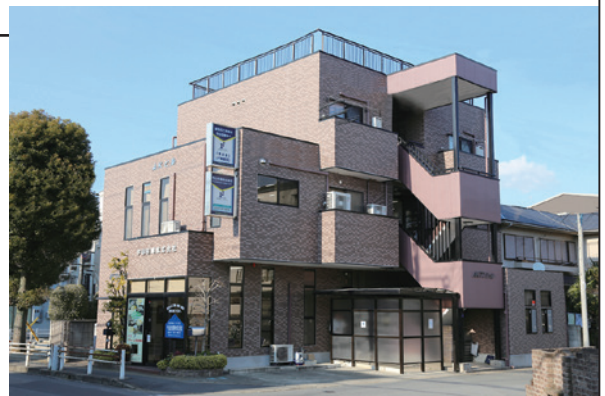
本社ビル外観
