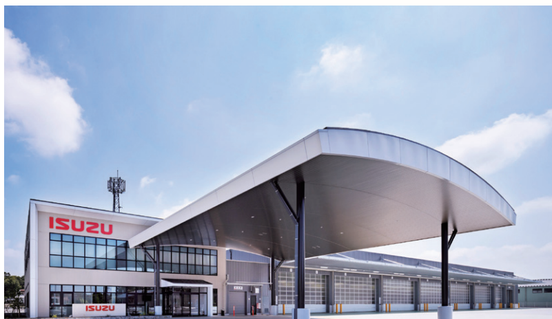
坂東サービスセンター外観 (写真提供：茨城いすゞ自動車株式会社)
