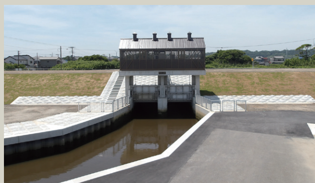
利根川右岸芦崎排水樋管新設工事(施工日:2023年7月31日)
