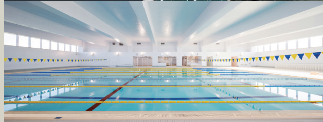
はさきマリプール建設工事(施工日:2023年1月31日)
