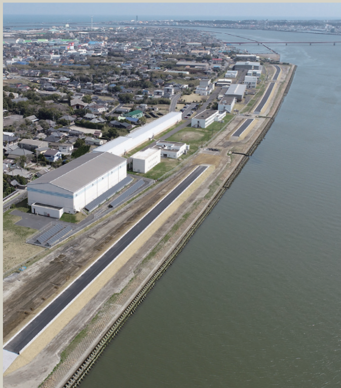
利根川左岸別所築堤工事(施工日:2022年3月30日)
