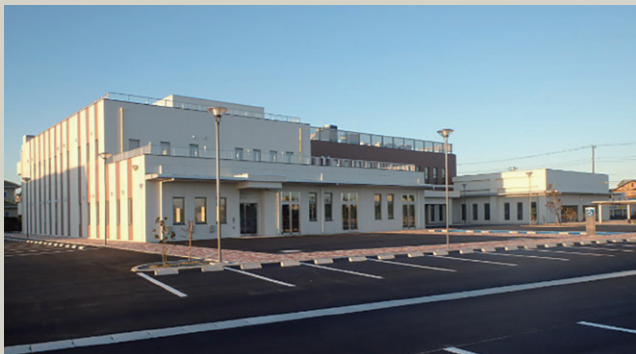
土合地域交流・保健福祉センター建設工事(施工日:2023年12月18日)
