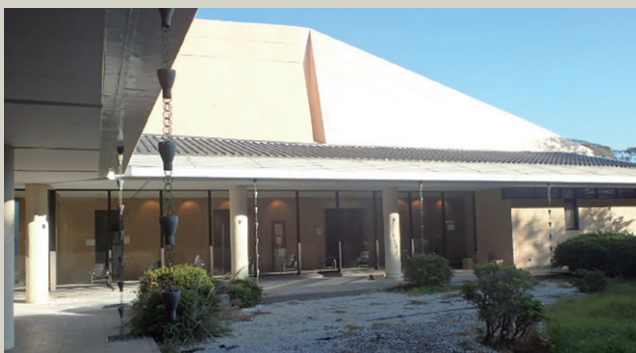
鉾子市斎場外壁改修その他工事(施工日:2023年12月18日)
