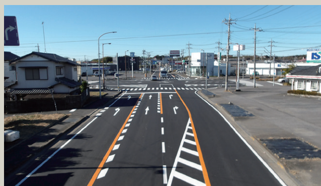
国道51号潮来市須賀地区舗装繕繕工事(施工日:2022年1月31日)
