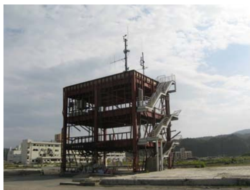
（写真 2）防災対策庁舎
