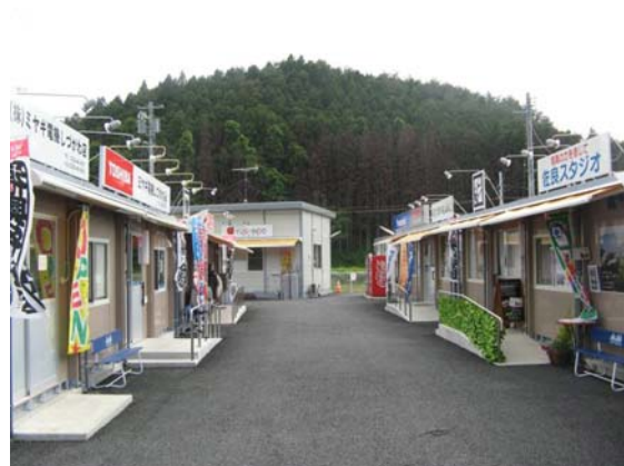
(写真12) 仮設商店街の一部
