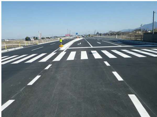
国道294号 道路改良舗装工事(その7)
