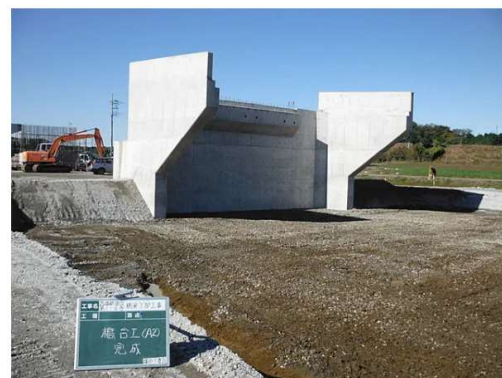
下妻市大宝 橋梁下部工事
