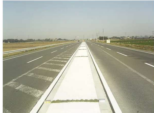
国道294号道路改良舗装工事
