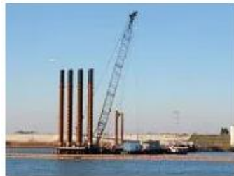
鋼管基礎打込
