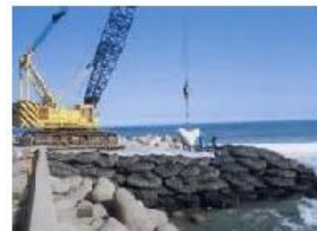
消波ブロック据付
