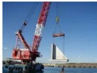
L型擁壁据付
