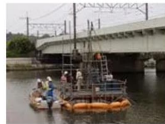
ボーリング足場
