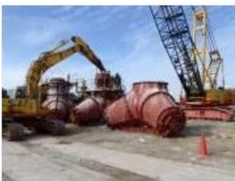
ブロック製作・据付
