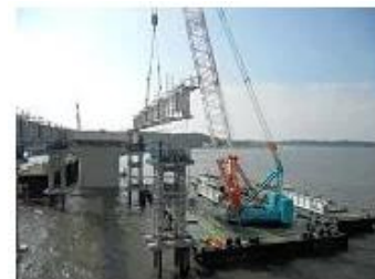
上部橋桁設置
