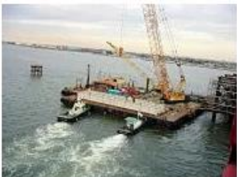
上部橋桁運搬
