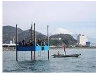
ボーリング足場 (SEP)
