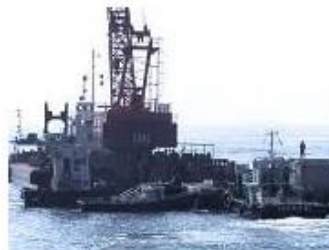
ケーソン据付
