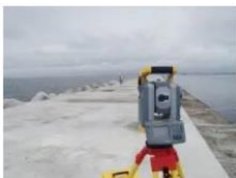
変状測量（自動追尾型 TS）
