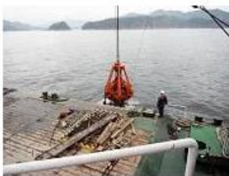
障害物撤去（ガレキ）
