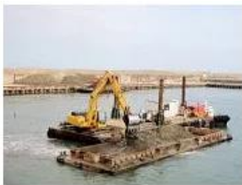
バックホウ浚渫
