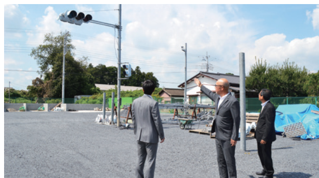
社内に設置された交通信号機の施工練習場
