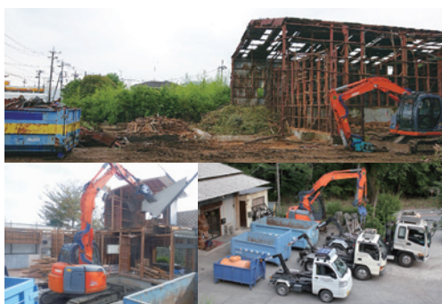
写真上および左下：解体工事の様子、 写真右下：産業廃棄物処理の様子
