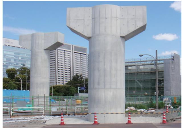
「自在R型枠」を使用した首都高大大井JCT高架工事
