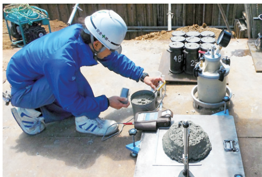
生コンクリートの現場代行試験の様子
