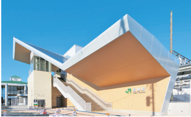
橋上化された羽鳥駅
