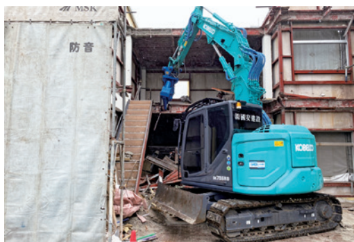
解体工事の様子
