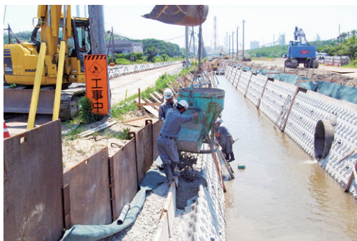
土木工事作業の様子
