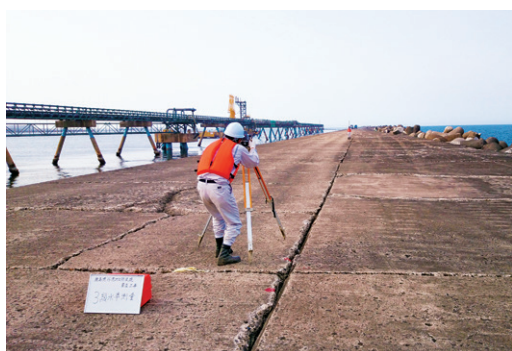
測量作業風景
