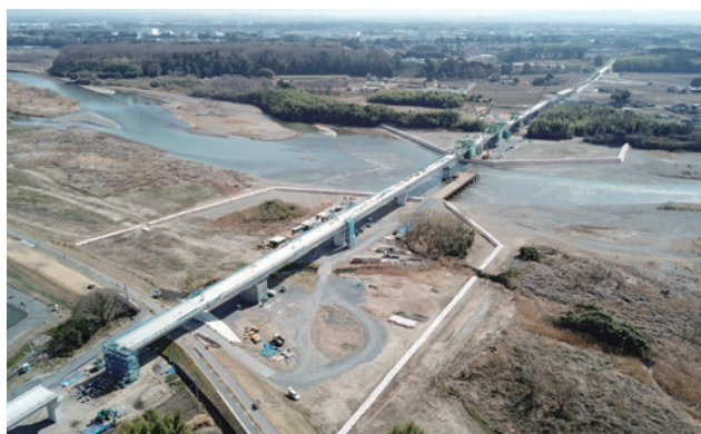
LRTの走る鬼怒川橋りょうの整備風景
