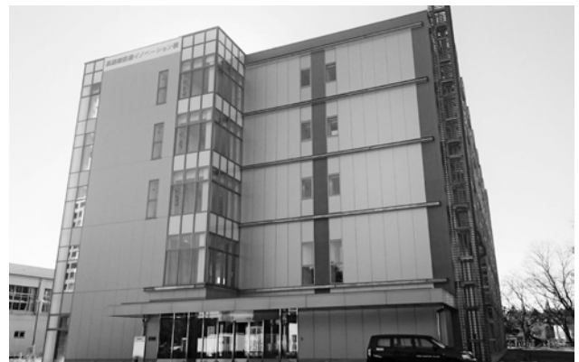
写真：筑波大学高細精医療イノベーション棟
