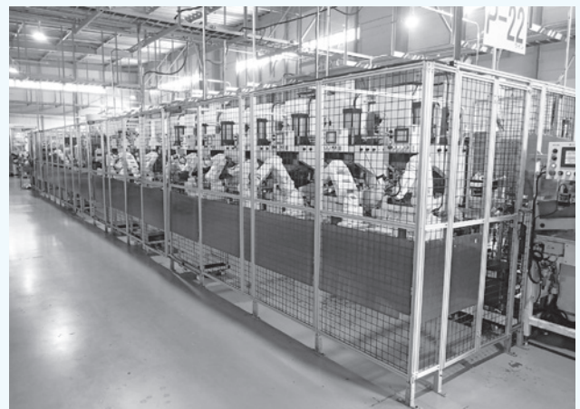
ロボットにより自動化されたパイプ加工ライン
