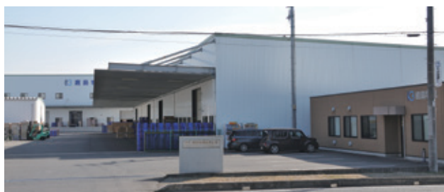
危険物倉庫を完備のもと医薬部外品や化粧品を中心に扱うつくば支店
