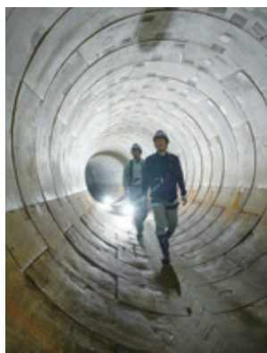
巨大雨水管の内部
