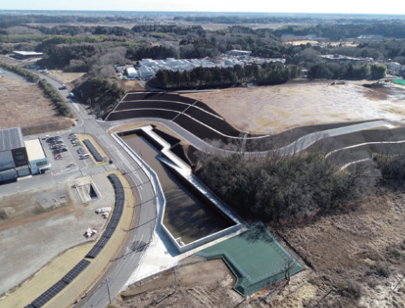
江戸崎土地造成調整池築造工事
