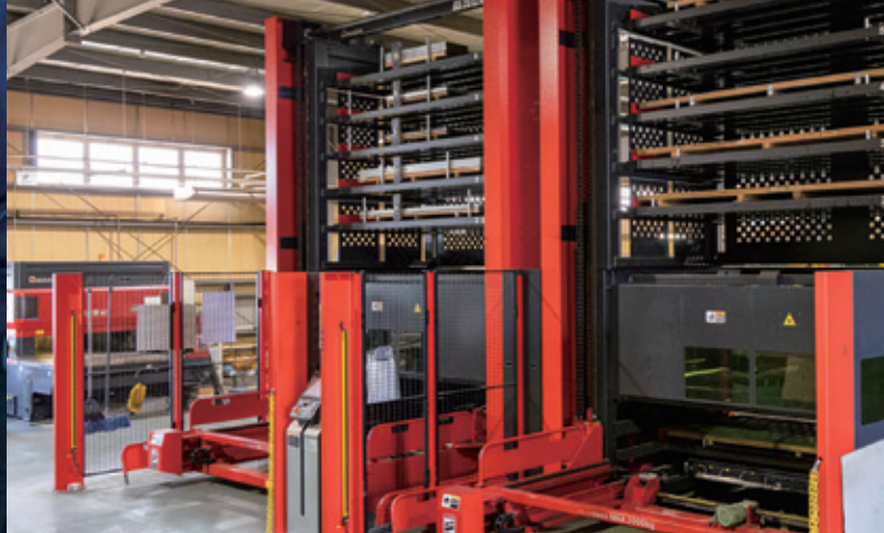
最新設備を導入した大規模な板金工場
