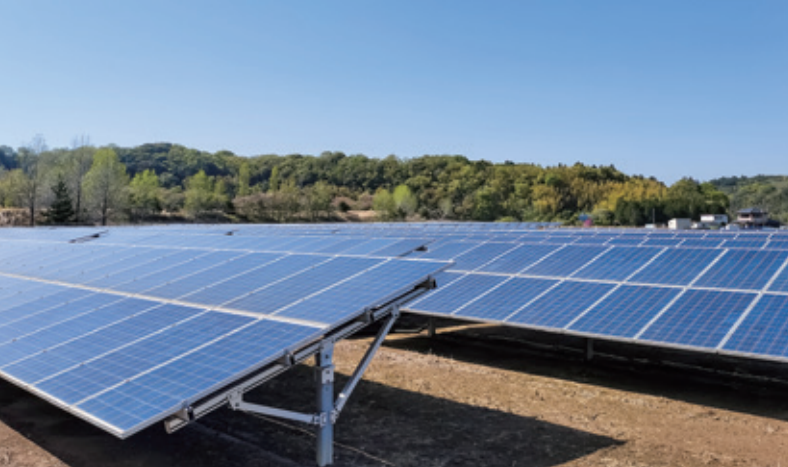
太陽光発電設備設置工事
