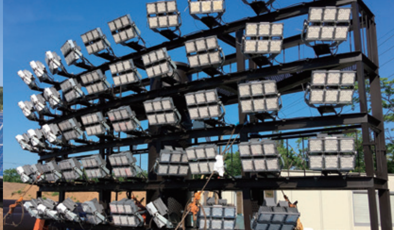
野球場ナイター照明設備工事
