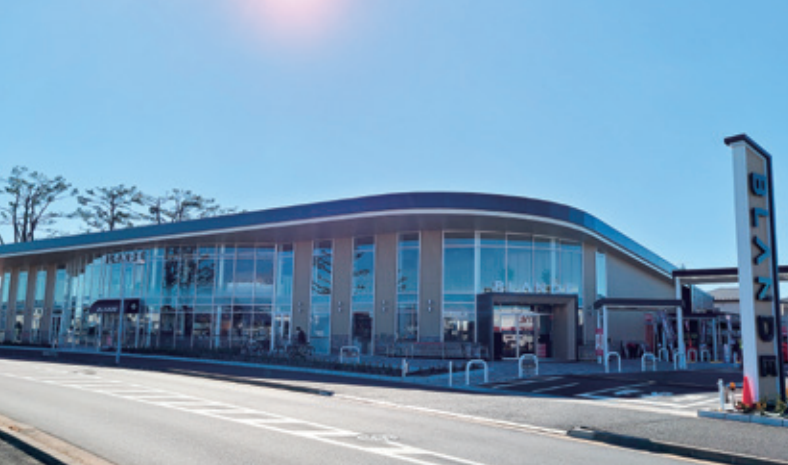
商業施設の電気工事施工事例
