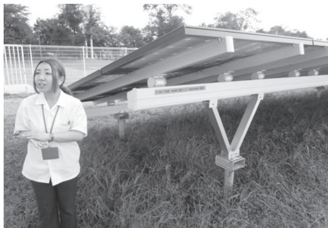
ソーラーパネルの支柱とアルミ架台
