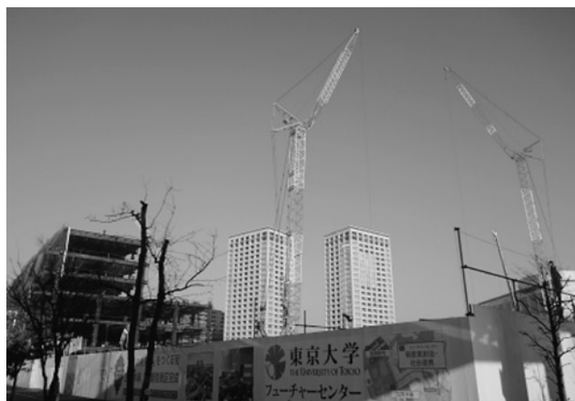
建設が進む148街区方面を望む
